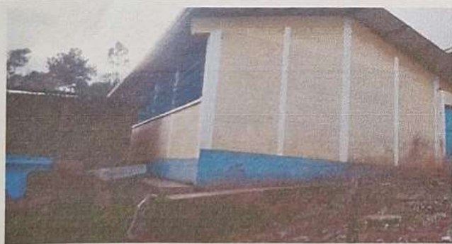
Foto 5: Fabricación e Instalación de balcones de hierro en ventana en la parte de atrás Módulo 2
