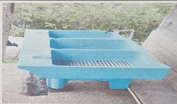
Foto 4: Sustitución de Pila de cemento de 2 lavaderos en el corredor de la cocina
