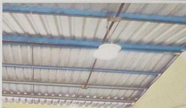
Foto 2: Sustitución de focos ahorradores Módulo 1 y 2
