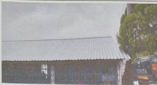
Foto 1: Sustitución de lámina troquelada aluzinc calibre 26 Módulo 1
